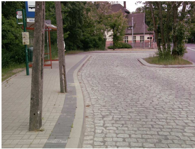
Fot. 18 Przystanek „Wielgowo” dla linii autobusowych nr 73 i 534 z wjazdem do zatoki utrudniającym prawidłowy podjazd do peronu oraz z latarnią zlokalizowaną zbyt blisko krawężnika.
