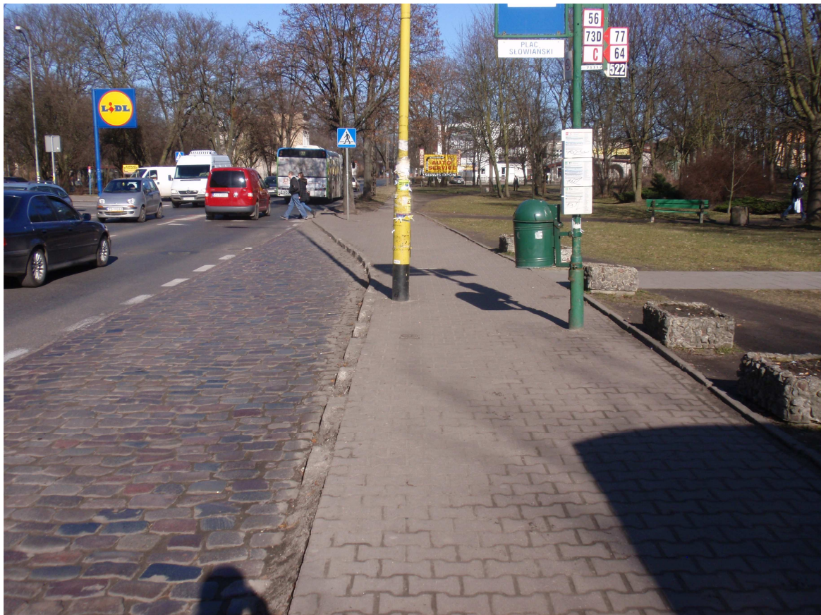
Fot. 9 Przystanek „Plac Słowiański” w kierunku Dąbia Osiedle z uszkodzonym krawężnikiem peronowym.
