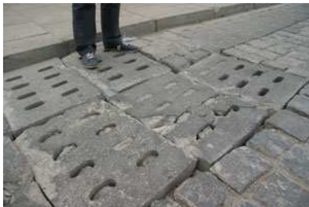
Fot. 21, 22 i 23 Przystanek „Berlinga” dla linii autobusowej nr 53 (po lewej dawna zatoka autobusowa, zdjęcia na górze to obecna zatoka zaadaptowana z miejsc postojowych dla samochodów osobowych, o tragicznym stanie nawierzchni i bez wyprofilowania na wjeździe oraz wyjeździe).
