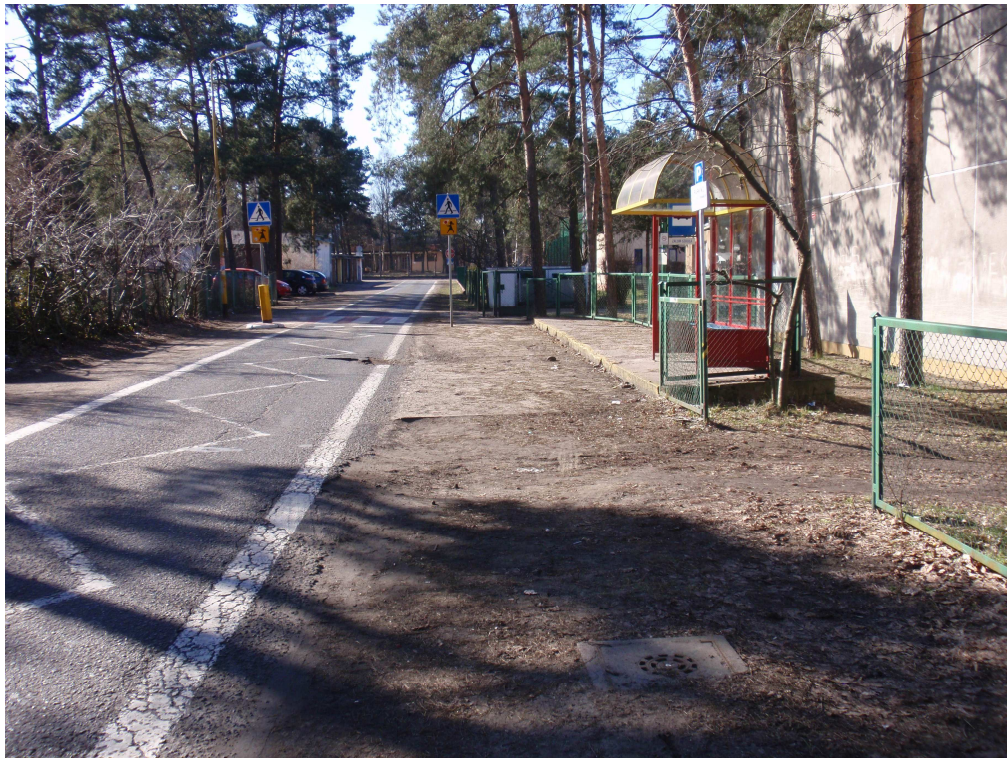
Fot. 29 Przystanek „Załom Szkoła” w kierunku Dąbia Osiedle zlokalizowany w miejscu uniemożliwiającym prawidłowy podjazd do zdeformowanego peronu przystankowego z wystającą wiatą przystankową oraz wygradzeniem szkoły.
