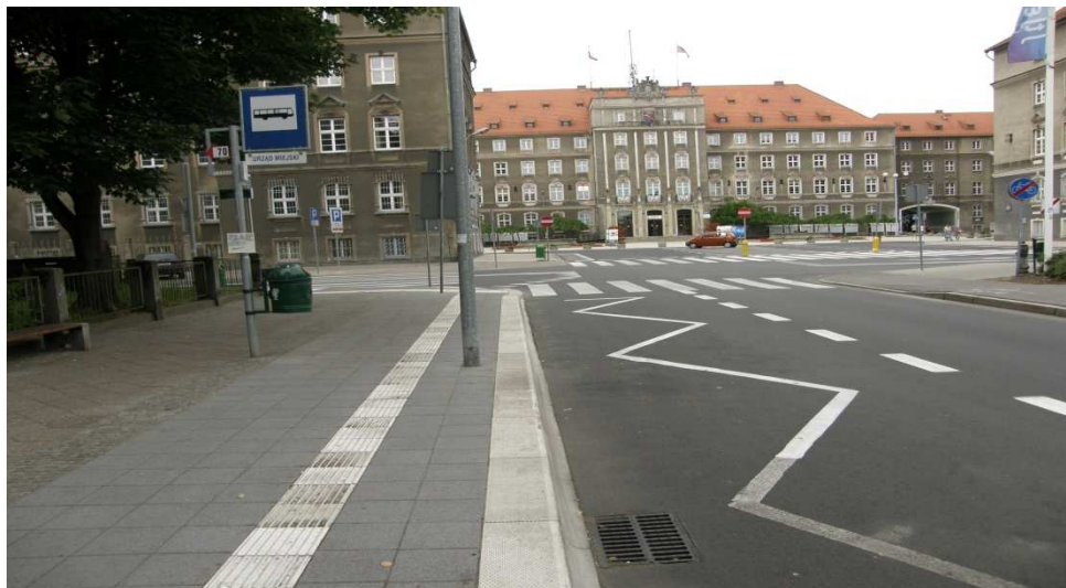
Fot. 31 Przystanek „Urząd Miasta” dla linii autobusowej nr 70 z latarnią oświetlenia ulicznego zlokalizowaną zbyt blisko krawężnika peronowego.
