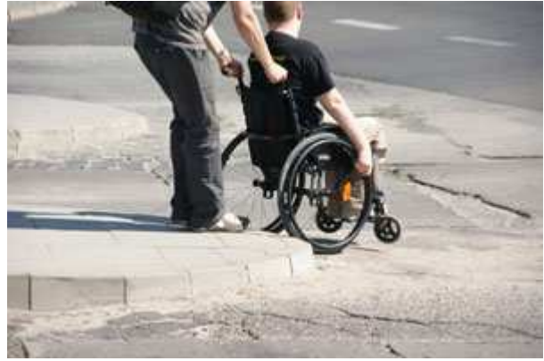
Fot. 11 Przystanek „Osiedle Słoneczne” dla linii autobusowych nr B, D, 54, 65, 71, 534. Perony wyremontowane, ale zapomniano o krawężnikach wtopionych umożliwiających osobom na wózkach inwalidzkich samodzielne poruszanie się. Nawierzchnia zatoczek obecnie w remoncie.
