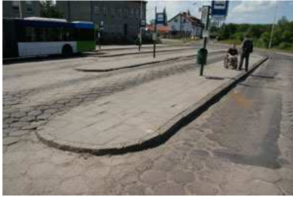
Fot. 10 Przystanek „Podjuchy Pętla” dla linii autobusowych nr 55, 55bis, 61, 64, 66 i 533 ze złym stanem nawierzchni i peronów.
