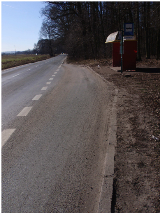
Fot. 12 i 13 Przystanki „Załom” w obu kierunkach z brakiem peronu przystankowego, a ponadto zatoka w kierunku Osiedla Kasztanowego jest za krótka i za wąska dla autobusu.
