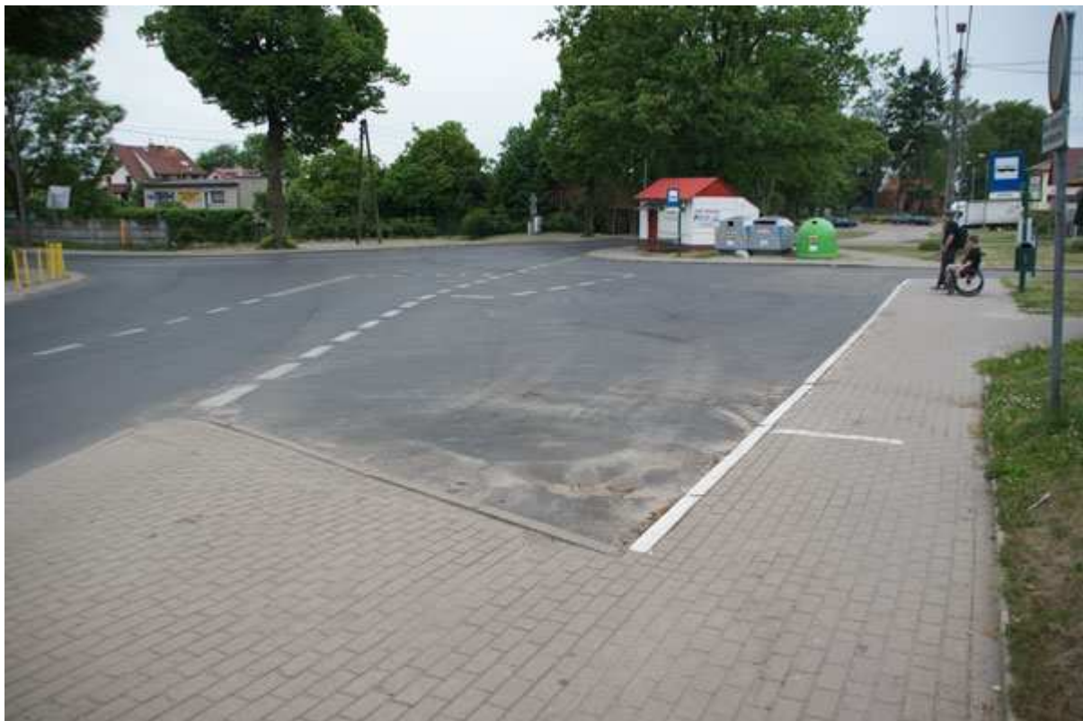
Fot. 28 Przystanek „Osów” dla linii autobusowych nr 51 i 532 z niestandardową zatoką uniemożliwiającą prawidłowy podjazd do peronu przy pierwszej próbie.
