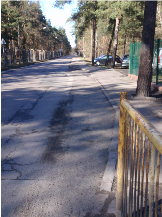
Fot. 30 Przystanek „Załom Szkoła” w kierunku Osiedla Kasztanowego ze zlokalizowanym w połowie peronu wjazdem na prowizoryczny parking oraz wygradzeniem peronowym wchodzącym w skrajnię jezdni na wjeździe do zatoki.
