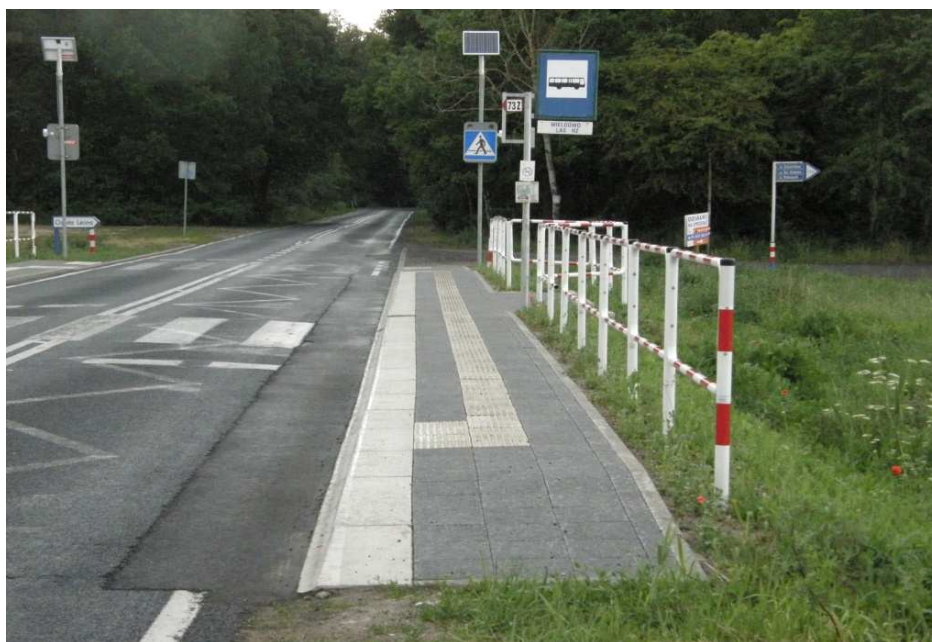
Fot. 32 Przystanek „Wielgowo Las” dla linii autobusowej nr 73 - na peronie w kierunku Dąbia błędnie wyprowadzono „ścieżkę prowadzącą” dla niewidomych. Zamiast na początku peronu, to na jego końcu.
