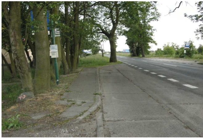
Fot. 26 Przystanki „Wolińska” dla linii autobusowych nr 77 i 522 ze zbyt krótkimi zatokami i drzewami na wjeździe i wyjeździe do/z zatoki.
