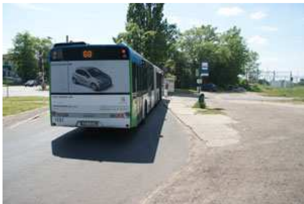
Fot. 5 Przystanek „Cukrowa” dla linii autobusowej nr 60 zlokalizowany na łuku uniemożliwiającym prawidłowy podjazd do za niskiego peronu z płyt betonowych.
