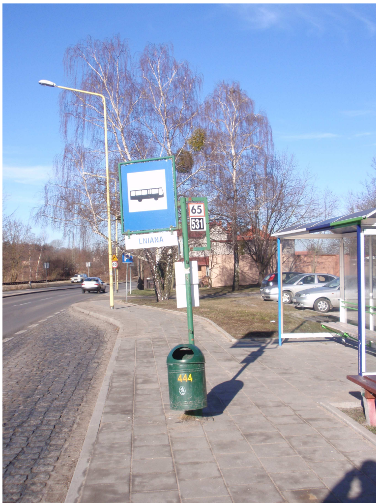
Fot. 20 Przystanek „Lniana” dla linii autobusowej nr 65 i 531 ze zlokalizowanym słupkiem przystankowym zbyt blisko krawężnika, uniemożliwiającym prawidłowy podjazd do peronu.
