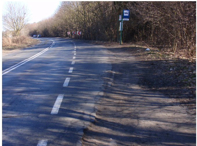
Fot. 12 i 13 Przystanki „Załom” w obu kierunkach z brakiem peronu przystankowego, a ponadto zatoka w kierunku Osiedla Kasztanowego jest za krótka i za wąska dla autobusu.
