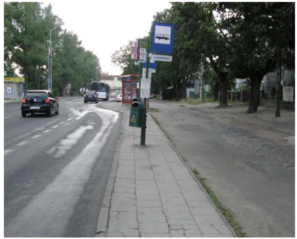
Fot. 19 Przystanek „Łubinowa” dla linii autobusowych nr B, D, 66, 71, 77 i 532 ze słupkiem przystankowym zlokalizowanym zbyt blisko krawędzi chodnika z powodu wąskiego peronu.
