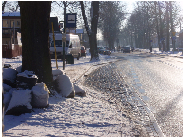
Fot. 27 Przystanek „Krzekowo Kościół” dla linii autobusowych nr 75 i 521 ze zbyt krótką zatoką.
