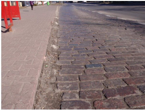
Fot. 7 i 8 Przystanek „Jugosławiańska” w obu kierunkach z uszkodzonym krawężnikiem peronowym.
