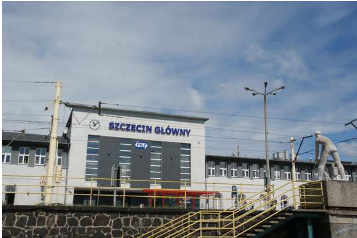
Fot. nr 1. Budynek główny dworca kolejowego.
