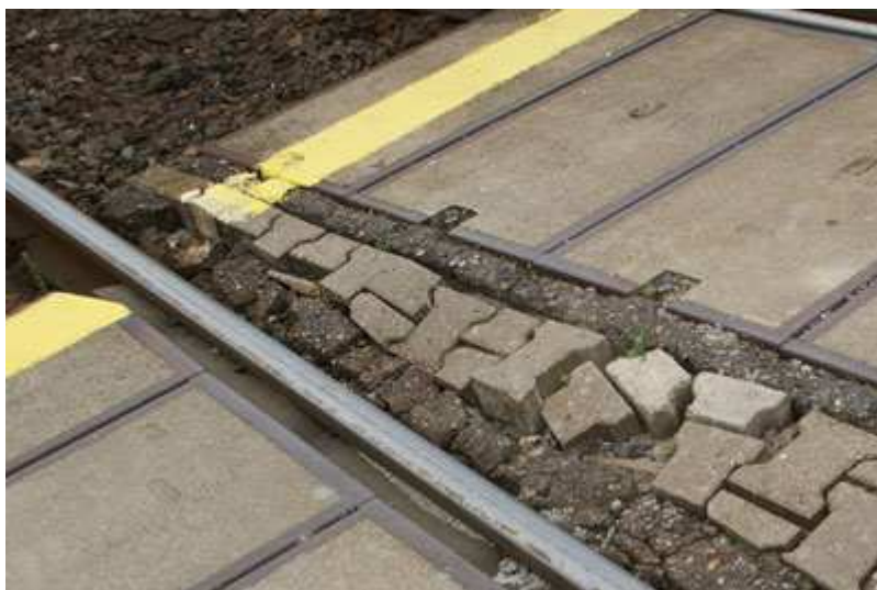
Fot. nr 24. Fragment uszkodzonej nawierzchni przejścia przez torowisko.
