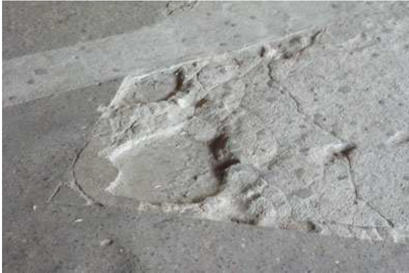
Fot. nr 26. Fragment posadzki na peronie pierwszym przy wyjściu z przejścia podziemnego.
