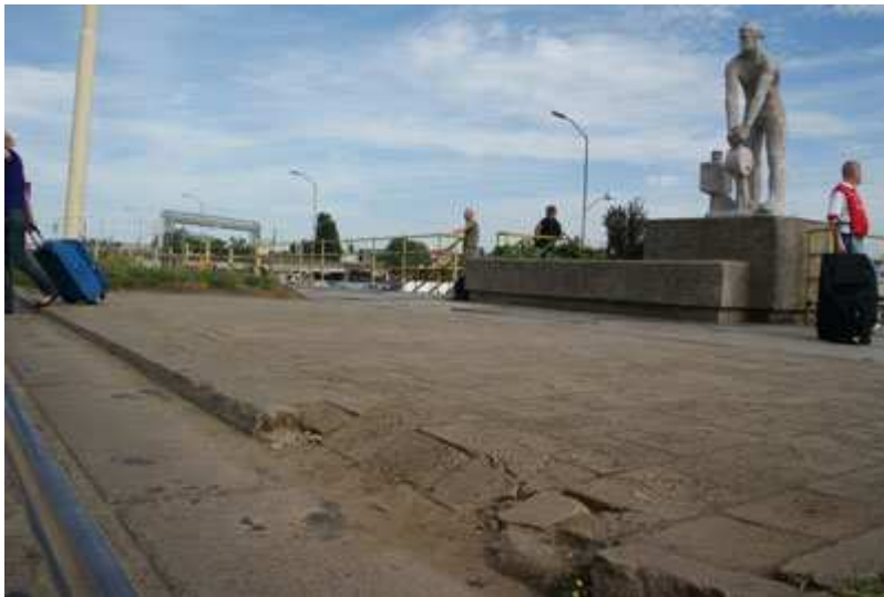
Fot. nr 2. Krawężnik przy przejściu przez torowisko tramwajowe.
