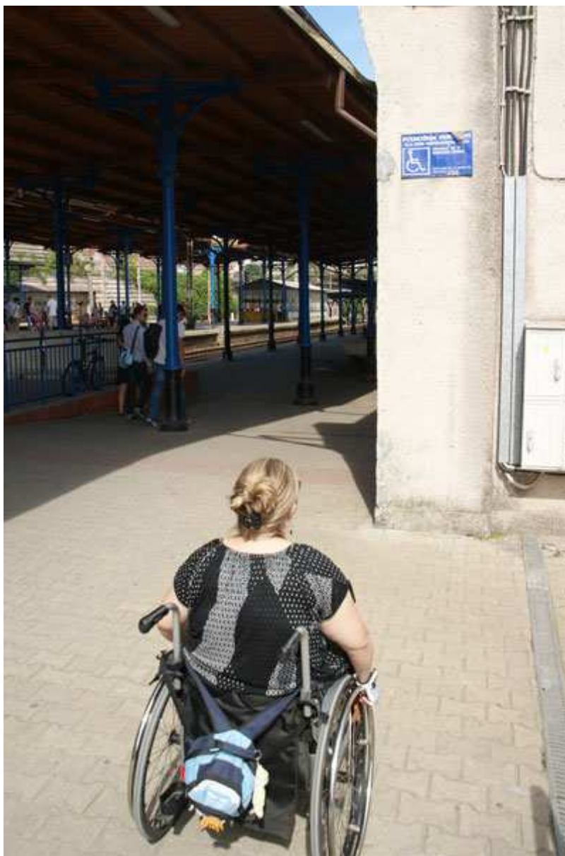
Fot. nr 14. Tablica informacyjna jest za mała, umieszczona za wysoko, zbyt zniszczona oraz z nieaktualnymi danymi.
