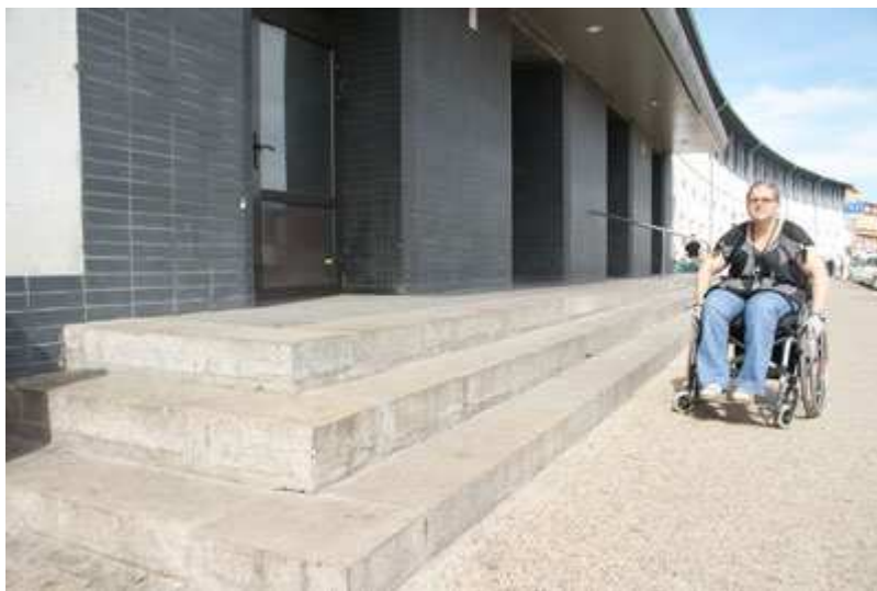
Fot. nr 4. Wejście główne nie jest dostępne dla wózkowiczów.
