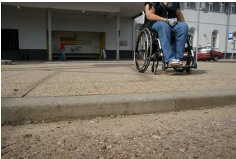
Fot. nr 3. Aby dotrzeć z przystanków tramwajowych na dworzec należy pokonać wysokie krawężniki.
