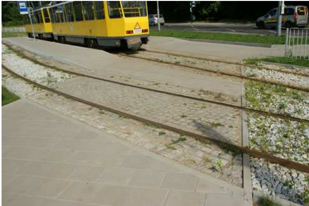
Fot. nr 5. Pętla tramwajowa. Dobrze, że pomyślano o obniżonych krawężnikach. Niestety nawierzchnia przy torach utrudnia poruszanie się między peronami.
