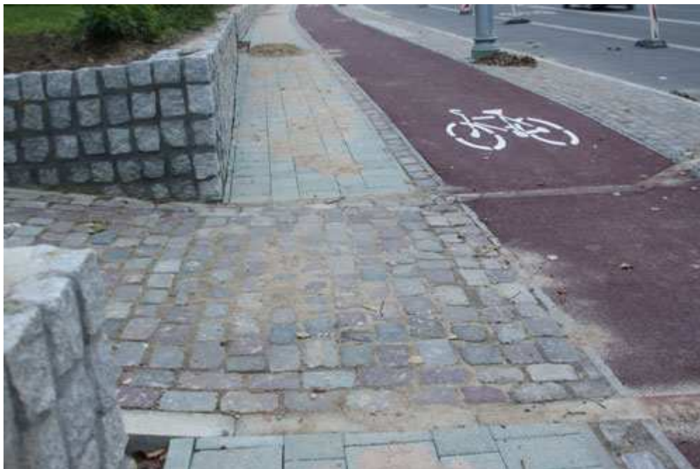
Fot. nr 2. W takich okolicznościach osoby na wózkach będą poruszały się po ścieżce dla rowerzystów, ponieważ posiada ona lepszą nawierzchnię (stosując taką kostkę brukową „wypycha” się wózkowiczów na ścieżki rowerowe). Czy taki efekt chcieli osiągnąć projektanci?
