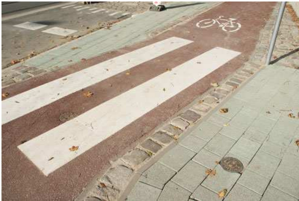
Fot. nr 3. „Obramowanie” ścieżki rowerowej. To „upiększenie” utrudnia wózkowiczom przejechanie przez przejście dla pieszych.
